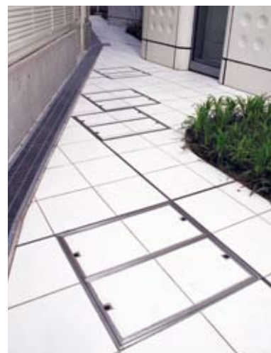
地下ピットの点検口に
