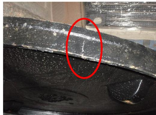
鉄蓋の側面部の破損
