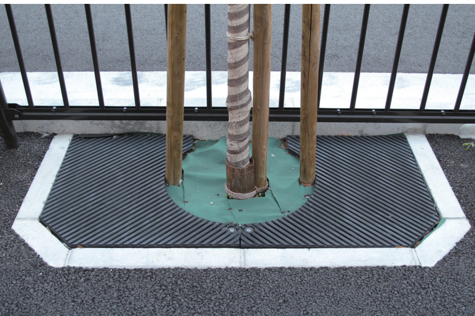
※防草シート施工 (別途) 仕様です。
