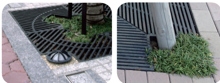
切欠き施工例
