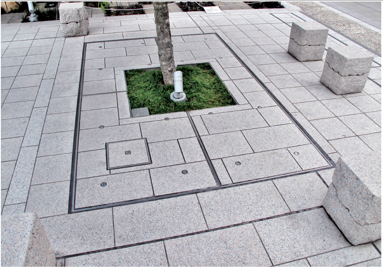
※夜間照明の設備点検用の小蓋を施した化粧蓋型グリーンメイトです。形状は長方形になっています。
