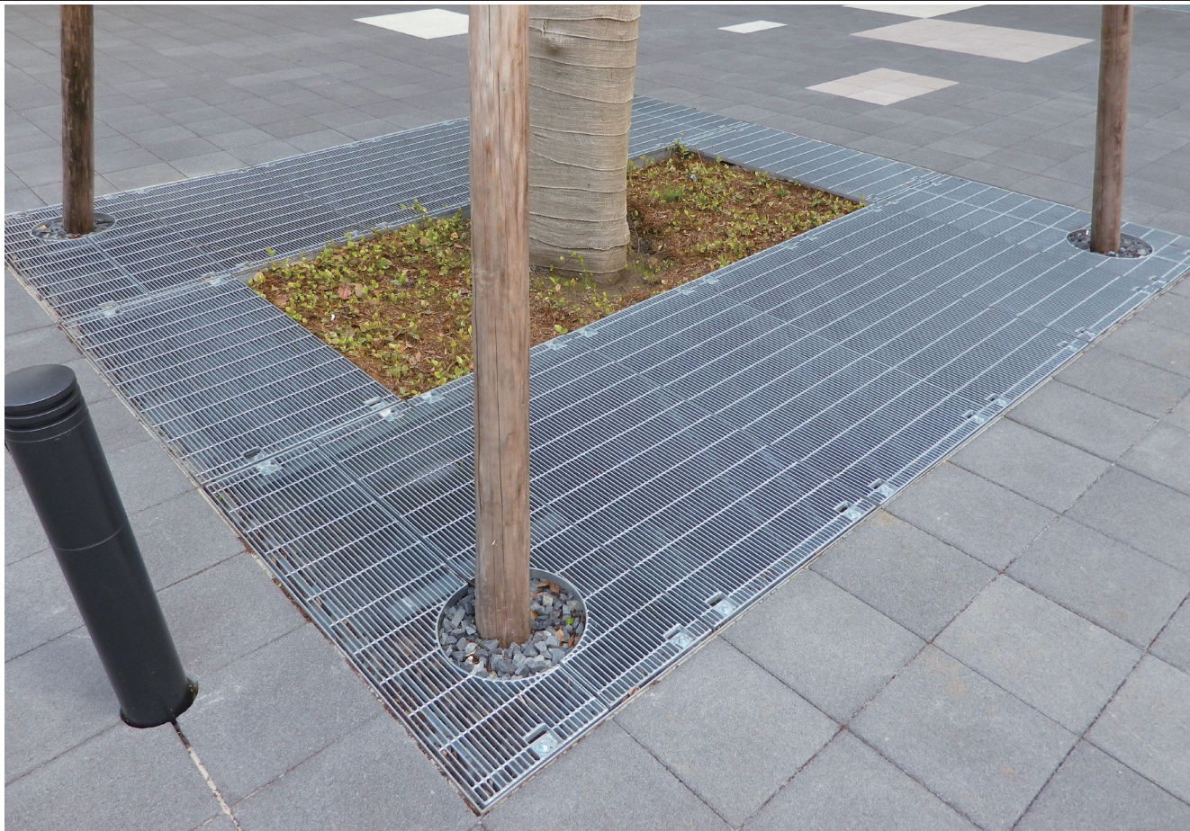
※敷地内の大型樹木を保護するためにスチール製ボルト固定グレーチングを用いたグリーンメイトです。四つ角には支柱穴加工を施しています。
