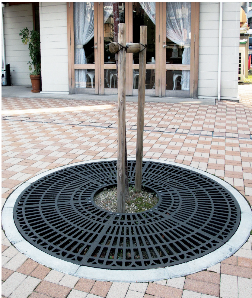
※写真は縁石受枠施工です。
