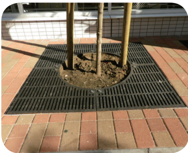
ブロックの目に合わせて施工可能です。
